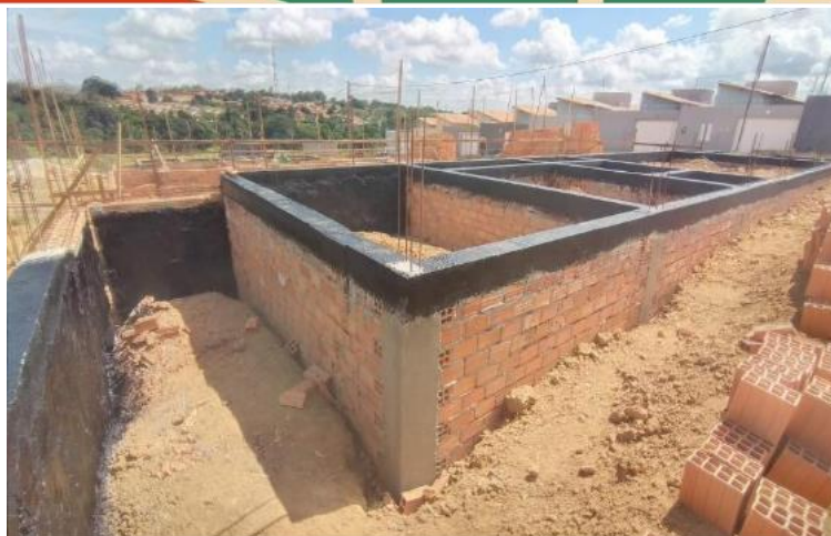
Figura 5. Vigas baldrame concretadas e impermeabilizadas, etapa fundamental da fundação acompanhada no canteiro de obras.
