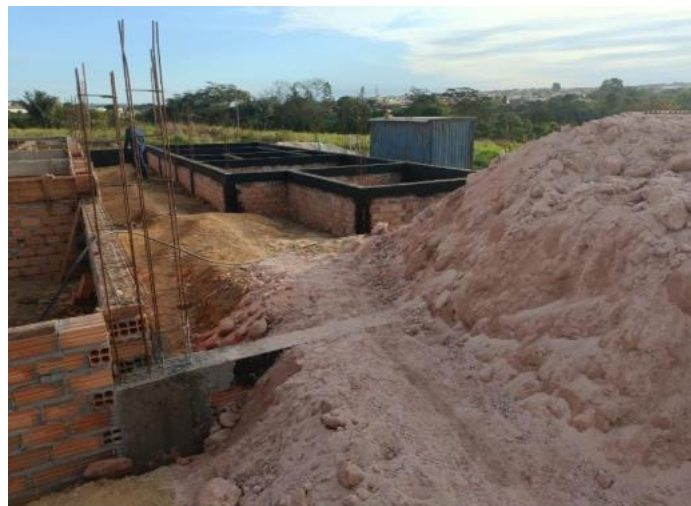
Figura 4. Volume de solo usado para o aterro da fundação e viga baldrame.
