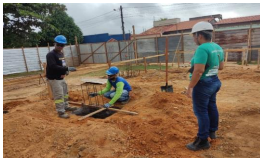
Figura 5. Acompanhando a concretagem de pilar Mercado Municipal
