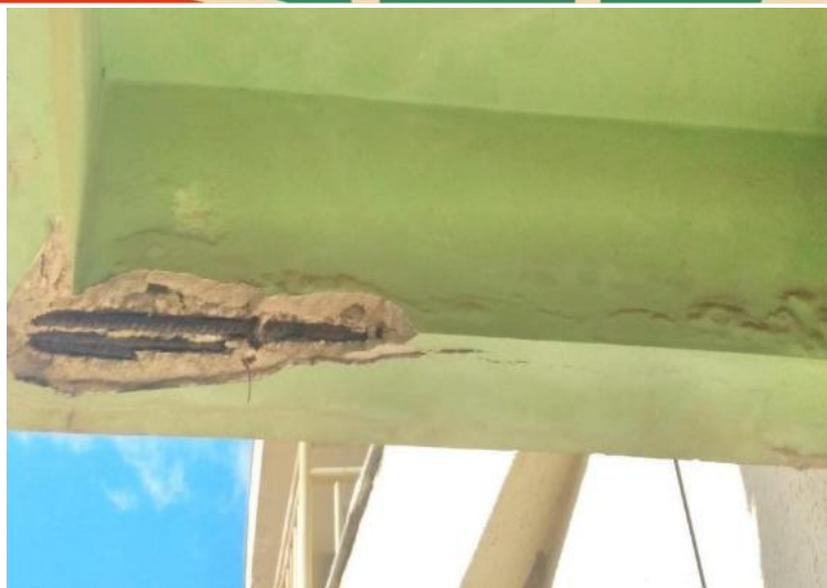
Figura 3. Registro fotográfico de fissura em elemento estrutural de concreto, uma das patologias encontradas durante vistoria técnica para elaboração de laudo.
