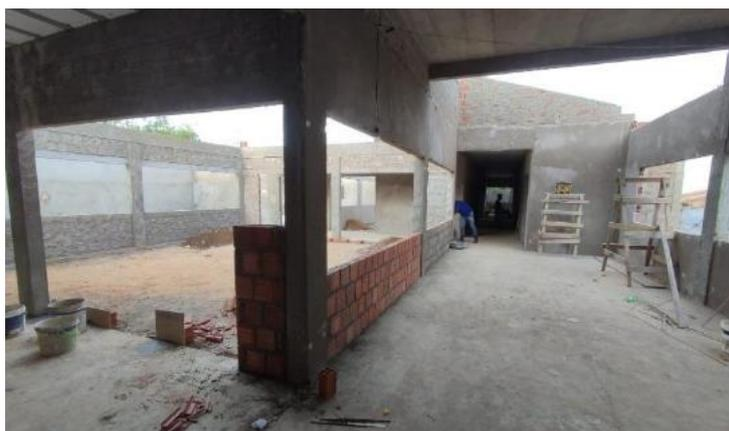
**Figura 9. Vista interna da obra (estágio de acabamento dos ambientes).**
