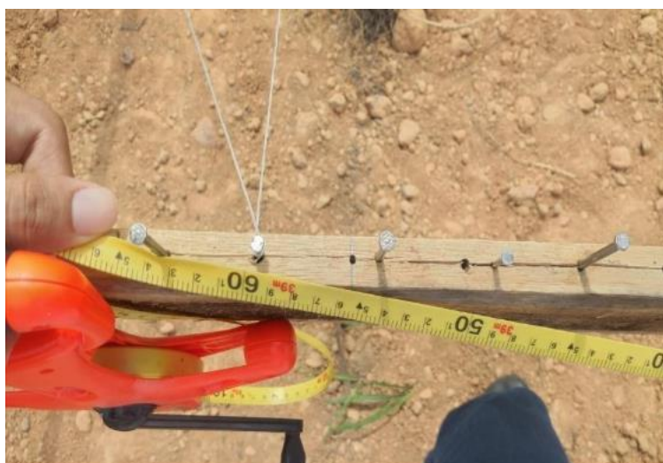
Figura 4. Checagem das medidas do gabarito da obra para garantir o esquadro e a precisão da locação.
