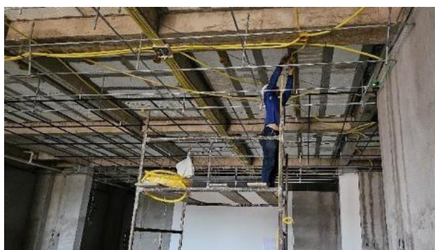
Figura 2. Instalação Elétrica do pavimento térreo localizado no Laras Hotel.
