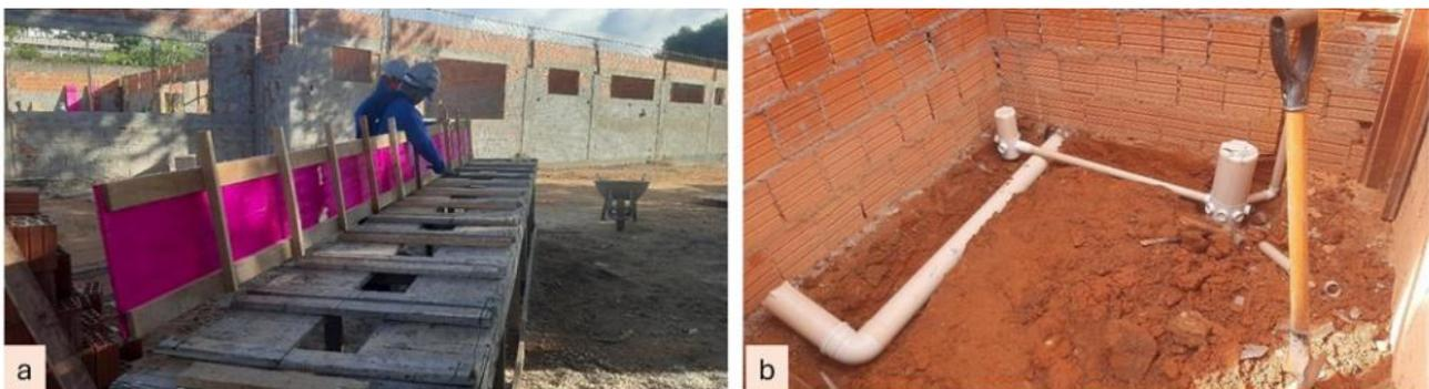
**Figura 6. (a) Confeção de formas para vigas e pilares, feitas sob medida por operários; (b) Instalações hidrossanitárias – execução das tubulações conforme projeto.**
