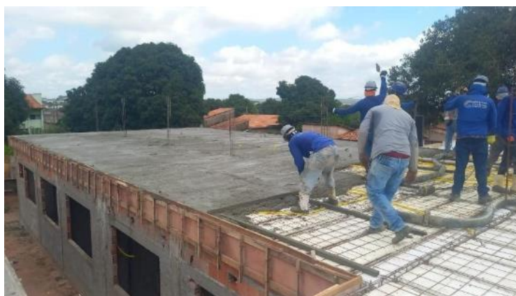
Figura 8. Concretagem da laje utilizando caminhão betoneira e equipamento de vibração.
