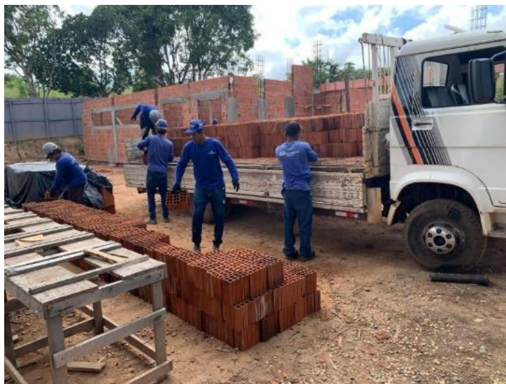
Figura 7. Recebimento de material (conferência e controle dos tijolos entregues).
