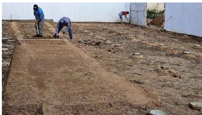
Figura 10. Aplicação de camada de areia
